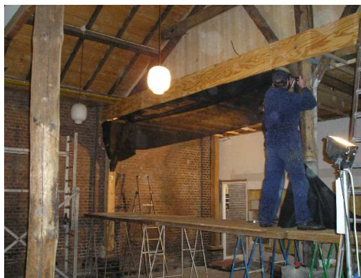
Bouwwerkzaamheden in het bezoekerscentrum
