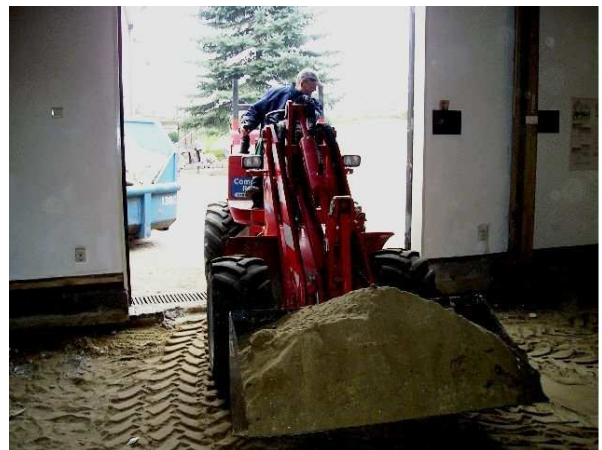
Sloopwerkzaamheden in het bezoekerscentrum
